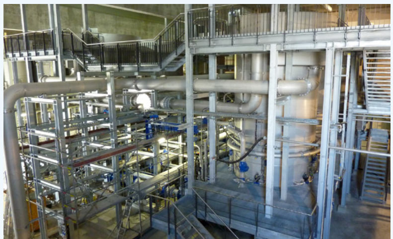
Bild 10: Die Schnellentcarbonisierungsanlage im Wasserwerk Langenau (September 2017)
